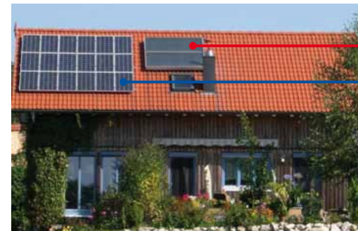
Abb. 5: Beide Nutzungsformen von Sonnenenergie auf einem Gebäude.
