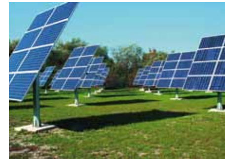
Abb. 10: Module auf Freiflächen können starr am Boden befestigt in eine Richtung ausgerichtet, oder an ein bewegliches Gestellsystem montiert sein und dann dem Sonnenstand nachgeführt werden. Freiflächenanlagen sind in der Regel durch Zaunanlagen vor unbefugtem Zugriff geschützt.
