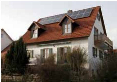
Abb. 6: PV-Anlage auf einem freistehenden Gebäude.
